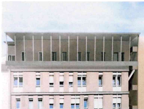
(febbraio 2023 il progetto delle camere protette e l'inizio dei lavori)
